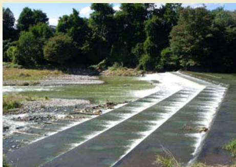
中井取水堰(H25年10月撮影)
